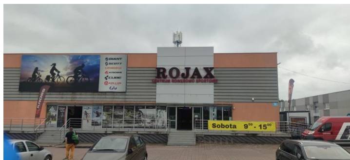
Zał. nr 1: Widok ogólny instalacji radiokomunikacyjnej.
